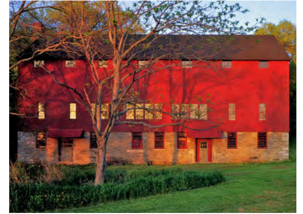
Woning met opslag - architect onbekend
