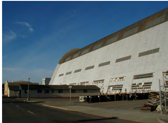
Hangar- architect onbekend
